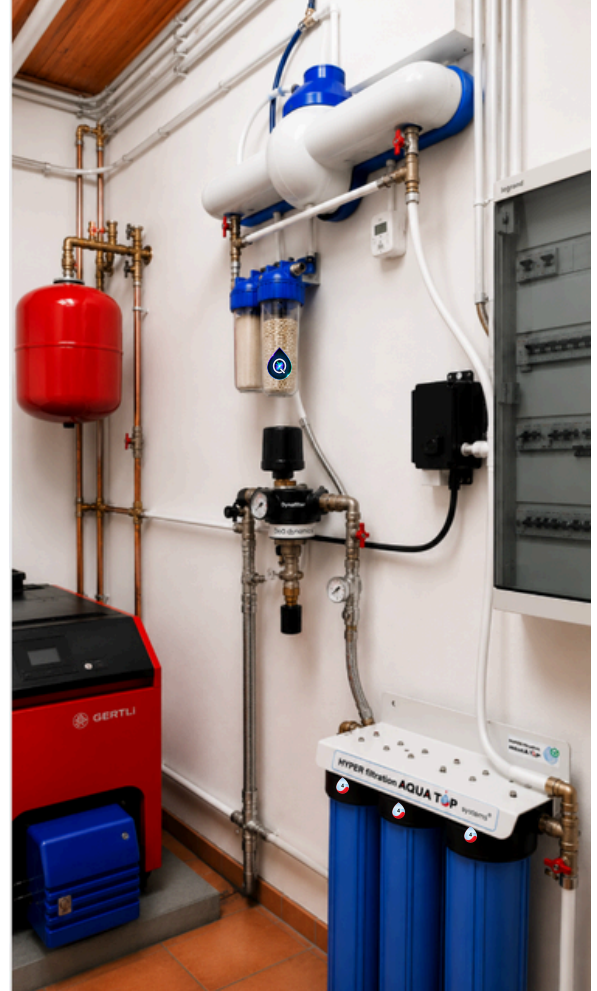
Potabilisation d'eau de source pour eau de consommation (hors réseau) TOP SYSTEMS
